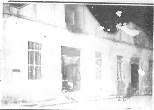
LOS ALMACENES EN CENDICADOS EN ARBOL SICO Y PESALVER.—Un aspecto de las ruinas destruidas por un toraz y rápido incendio.
